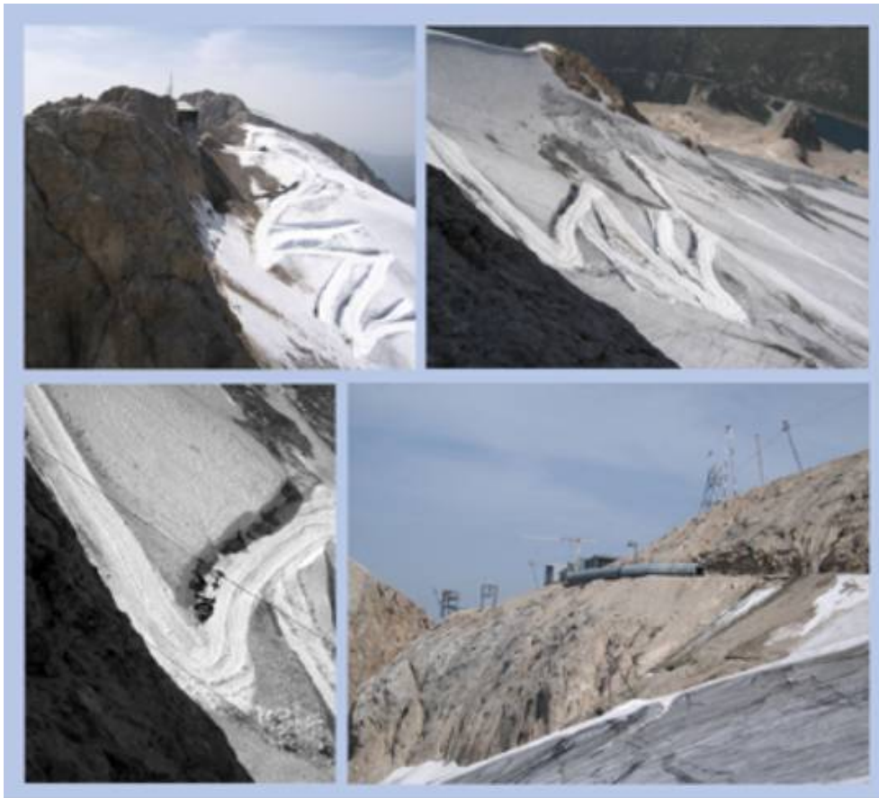
Fig. 2 – Alcune delle foto scattate dagli ambientalisti di Mountain Wilderness che hanno fatto scoppiare il caso della pista-cantiere in Marmolada (foto: R. Vaia, per gentile concessione di MOUNTAIN WILDERNESS).
