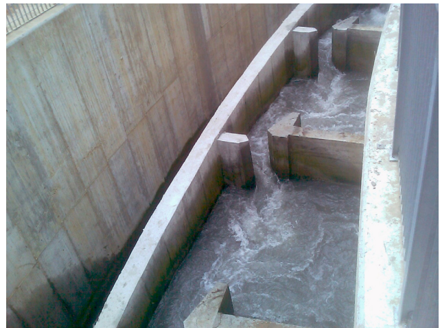
Fig. 1 - Passaggio per pesci sul fiume Dora Riparia. Fig. 1 - Fish pass on Dora Riparia river.
